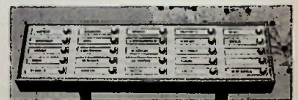
Afb. 4. Druktoets-tableau voor afzonderlijke inschakeling van alle telefoondistricten
